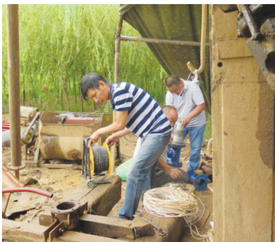
水文勘探孔静止水位恢复测量
