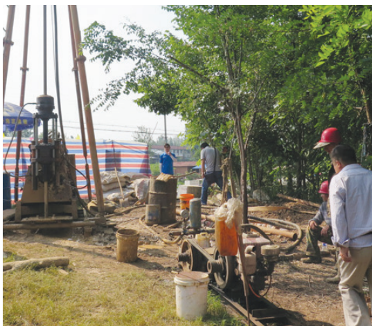
现场热响应勘探孔施工
