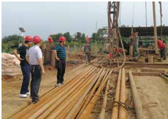
咸阳市地质调查项目钻井现场
